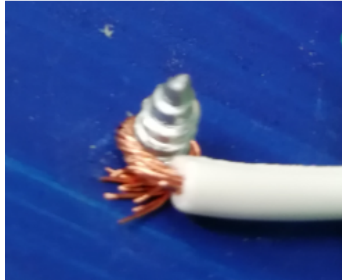
Ilustración 13 Vista de ejemplo de cómo deberá cada cada conexión entre el cable y el tornillo.
